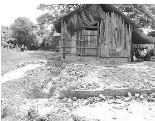
敷地確保のため木造の旧校舎を半分壊して工事開始
