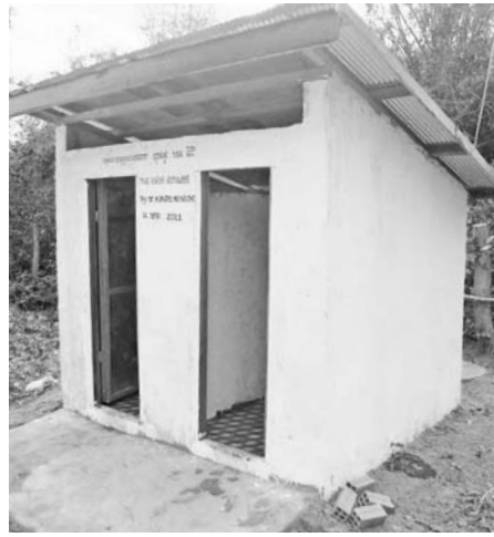
校舎の裏に完成したトイレ
