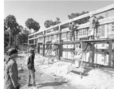
約60%仕上がった神戸ユネスコ協会寄贈の校舎
