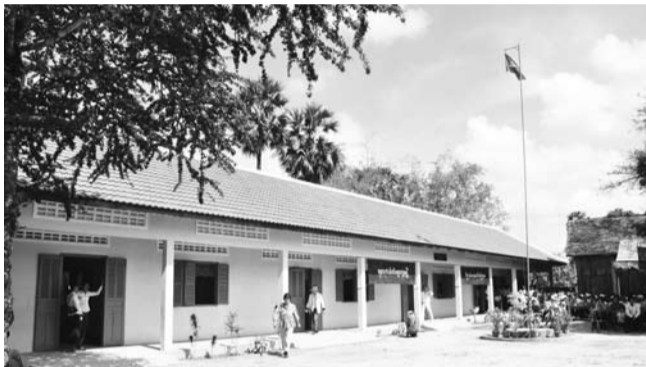
完成した新校舎
