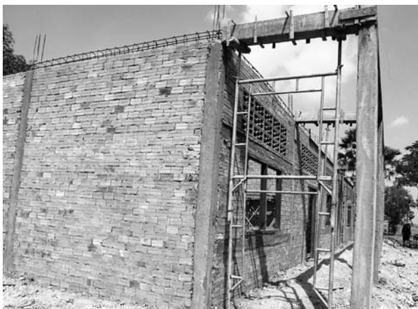
5月に完成予定の新校舎
