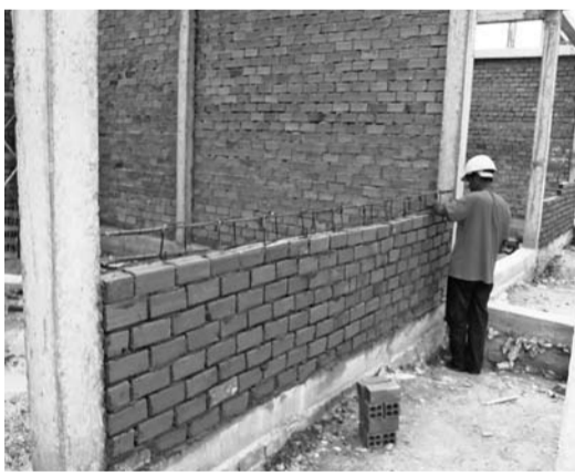
建設工事の50%が終了
