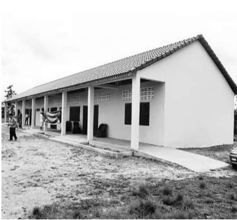
完成した4教室の校舎
