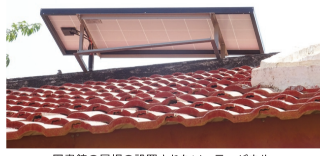
図書館の屋根の設置されたソーラーパネル
