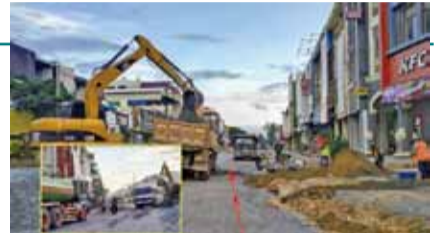
工事中のジェムリアップ市内
