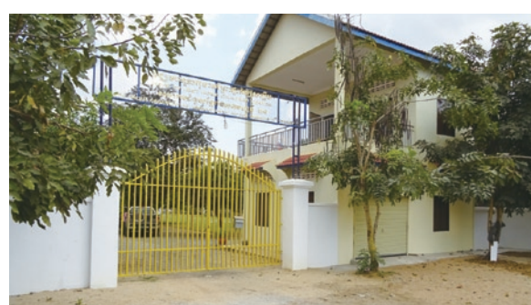
完成した塀と正門
