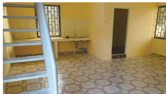
2階建ての一階部分を改修
