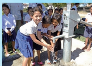
ロッド小学校に完成した井戸
