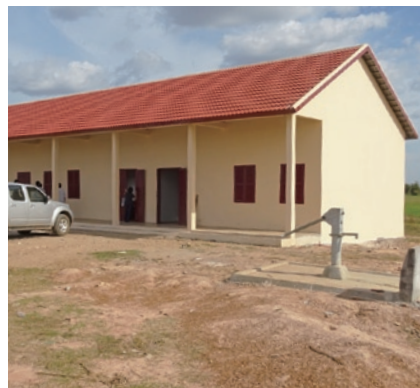
ほぼ完成した小学校の校舎
